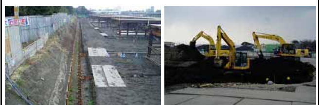
荒川左岸南部流域下水道 7号水処理築造土木1工事 岩崎工業様 蓮田なごみ病院新築工事
